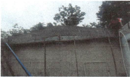
Foto 3: TRABAJANDO EN LEVANTAMIENTO DEL TECHO
