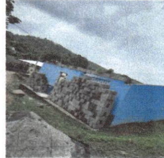
Foto 2: TRABAJANDO EN EL LEVANTAMIENTO DE LA PARED PARA QUE ESTE MAS ALTA
